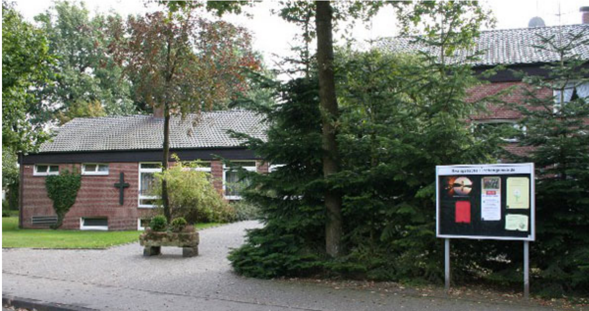
Gemeindehaus am Lenhartzweg in Ladbergen
